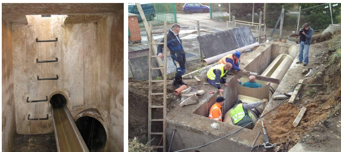
Obr. 1 Původní odlehčovací komora (vlevo) a instalace CSO-T 6.11.2012 (vpravo)
