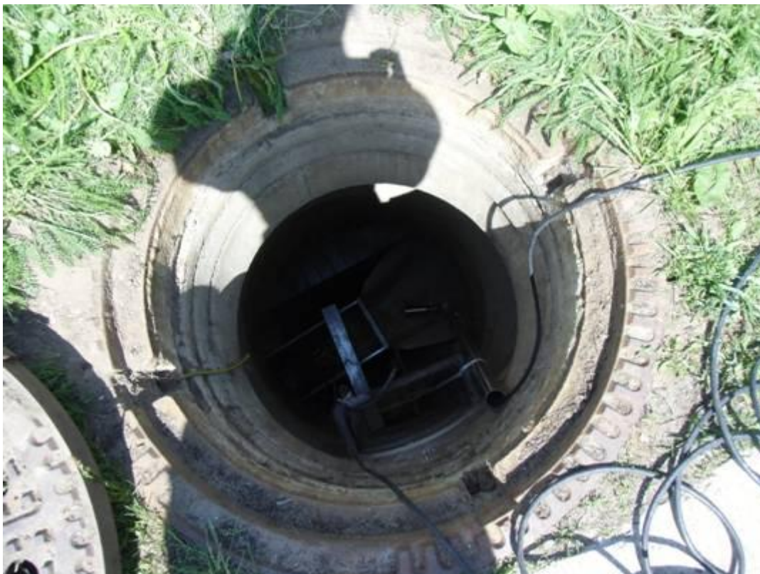
Obr. 2 Osazení měrného žlabu a umístění měřících sond
