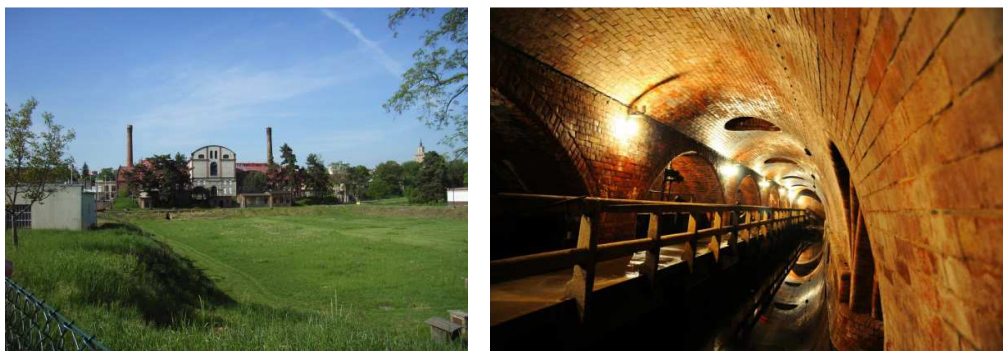
Obr. 1 Původní čistírna odpadních vod v Praze - Bubenci
